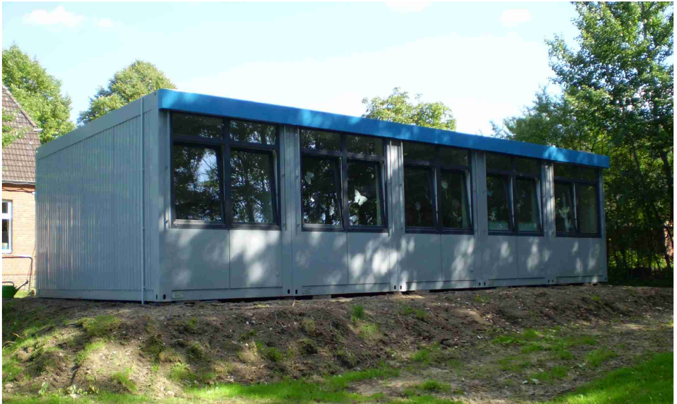
Der neue Container für die 2. Klasse. Weil diese Klasse Elefantenklasse genannt wird, wäre er das „Elefantenhaus“. Hinter dem linken Fenster ist der Eingang, hinter dem sich die Garderobe befindet. Dahinter ist auch die Ecke der Schule zu sehen. Vier Elemente ergeben den Klassenraum.
